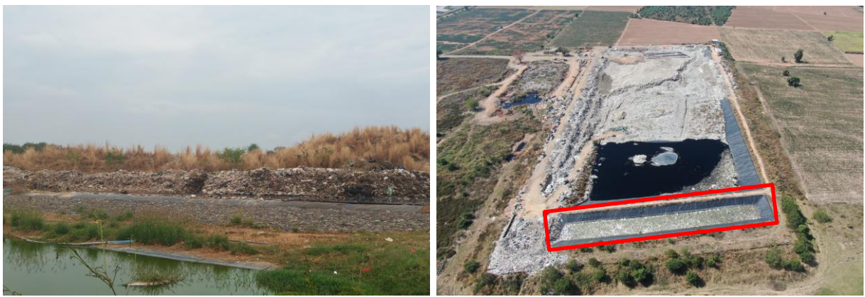
รูปที่ ๖ บ่อบำบัดน้ำเสียระยะที่ ๑ (ซ้าย) และ ๒ (ขวา)
